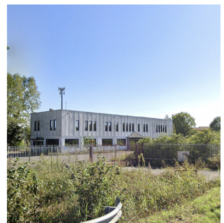
Viste dell'area di intervento
