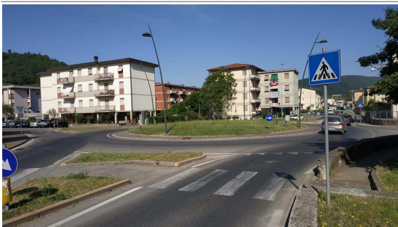
Figura 4 -Pista ciclabile proveniente da sud (foto scattata da via Toscanini)
