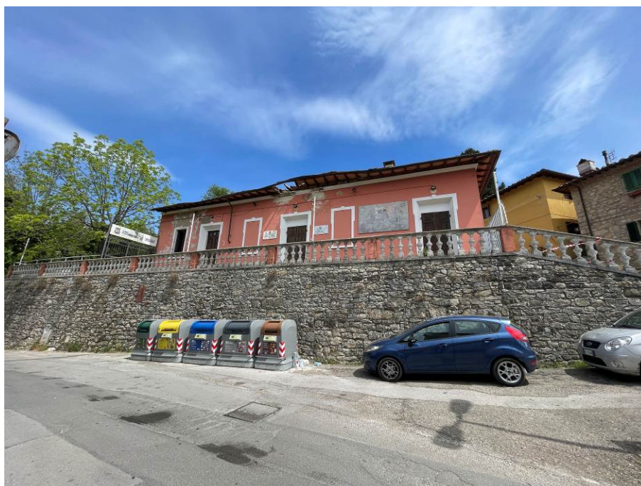
Figura 1 - prospetto su via del Fosso Sieci
