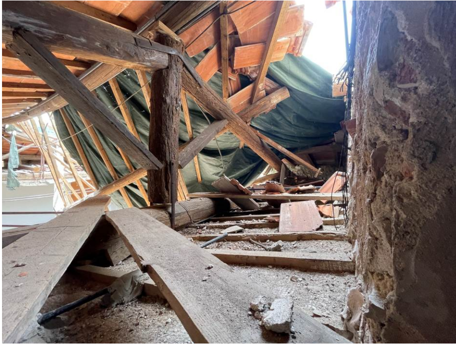
Figura 7 - particolare della capriata C1
