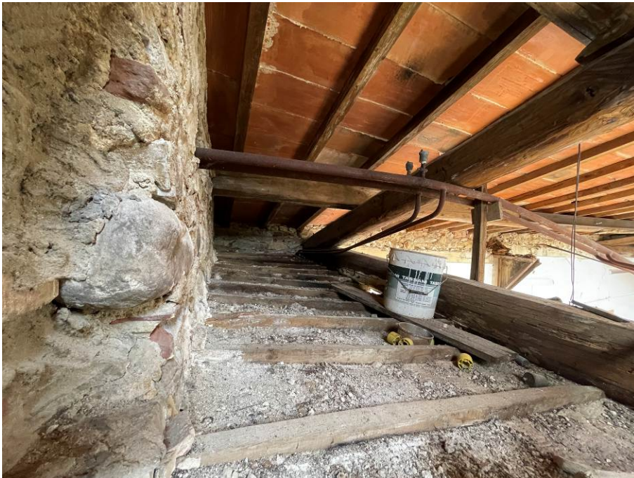
Figura 8 - particolare della capriata C1
