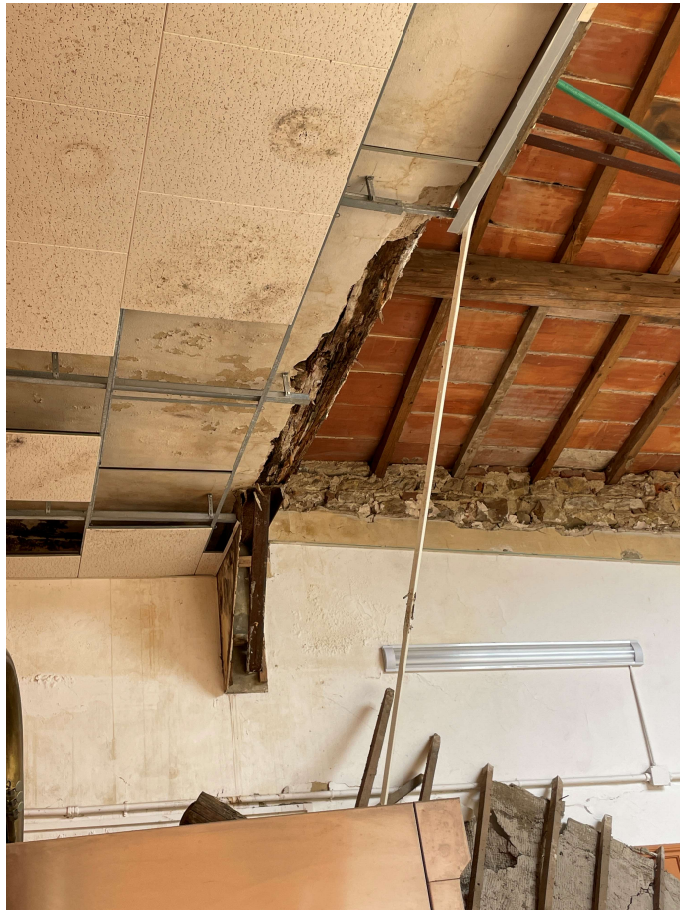
Figura 5 - particolare della capriata C1
