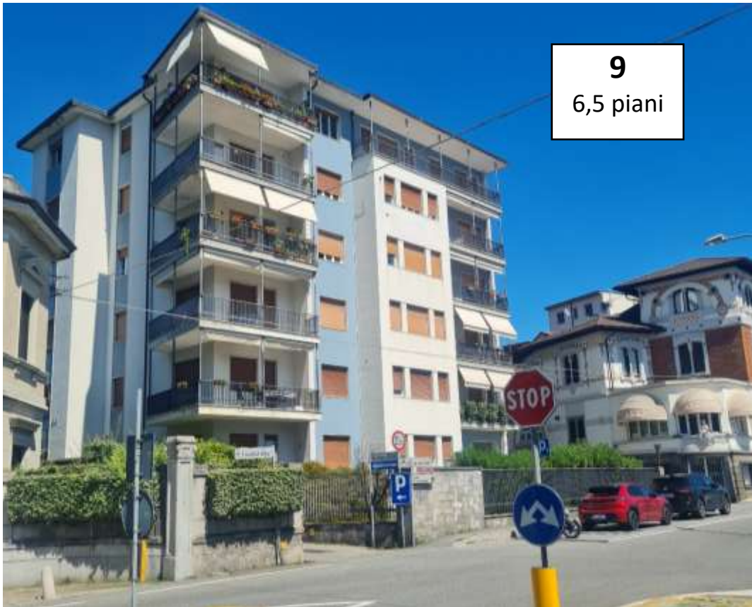
Vista da Via Castelli
