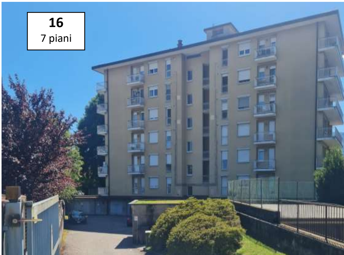
Vista da Via Fiume
