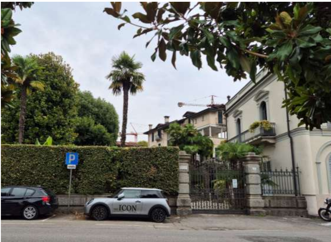
Vista attuale da campi da tennis in via Tonolli - si vede il tetto dell'edificio allo stato di fatto, mitigato dalla vegetazione
