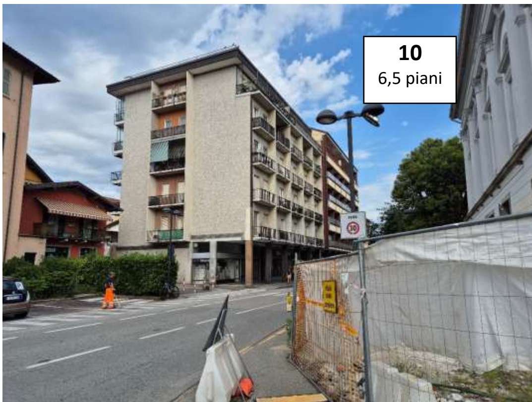
Vista da Via Castelli
