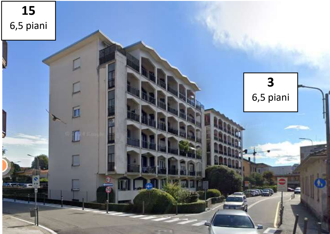
Vista da via castelli
