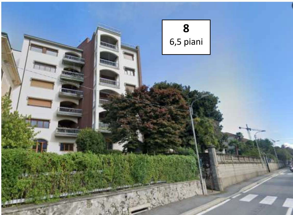
Vista da via castelli
