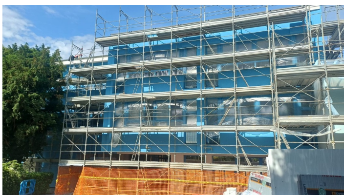
Secondaria via Bizet 1 – applicazione cappotto
