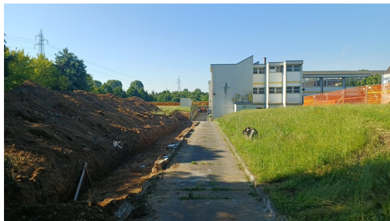
Iqbal Masih – Lavori sul vialetto
