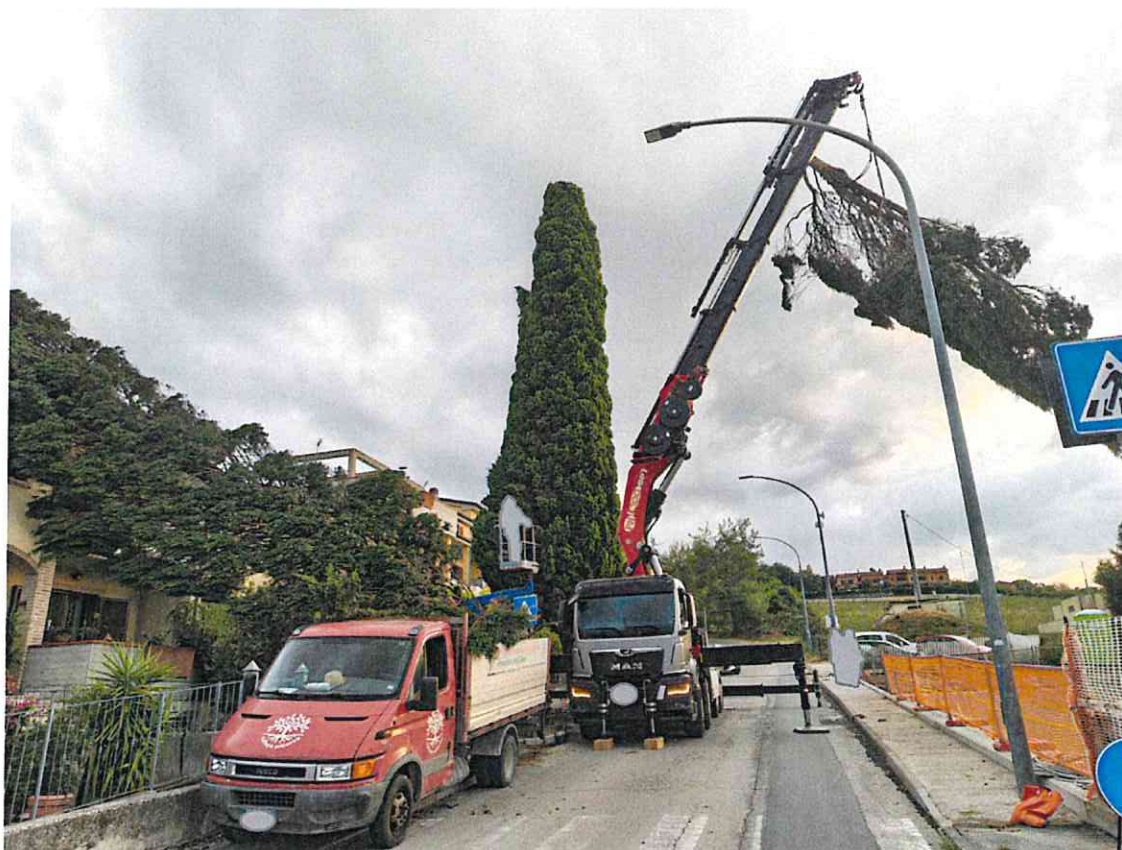
Via Abbadia – fraz. Abbadia
