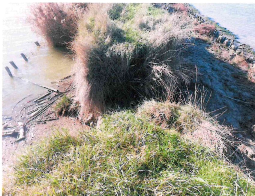
Punti di massimo cedimento arginale in cui si è creata la prima voragine
