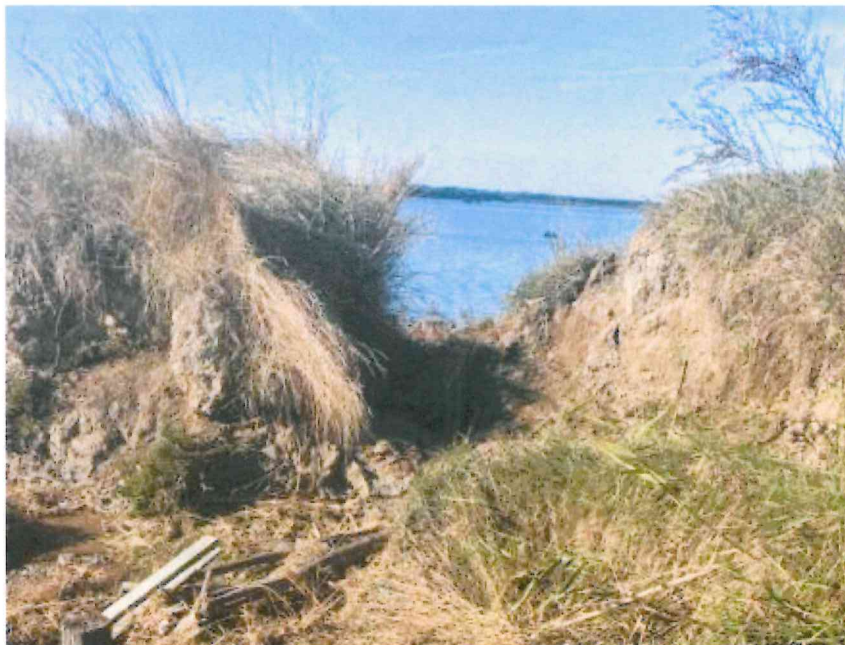
Punti di massimo cedimento arginale in cui si è creata la seconda voragine
