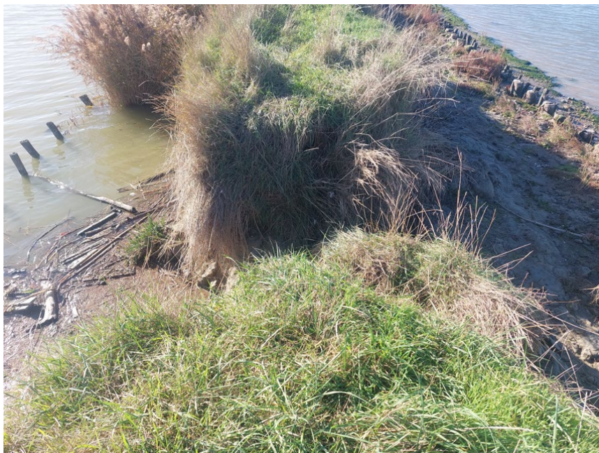
Punti di massimo cedimento arginale in cui si è creata la prima voragine
