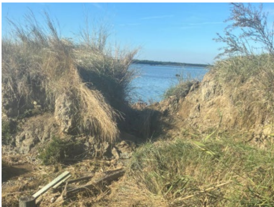
Punti di massimo cedimento arginale in cui si è creata la seconda voragine
